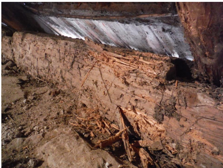
12. felvétel: Délnyugati tetősík – talpszelemen
