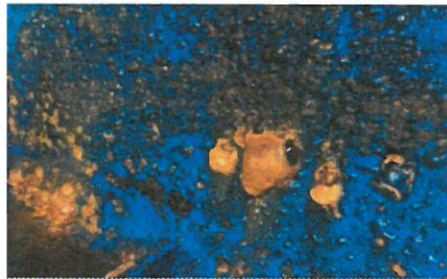
2.kép Csőoszlop belső felülete
