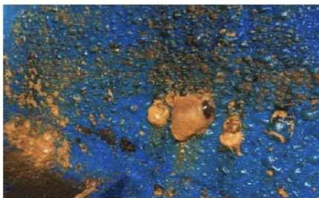
2.kép Csőoszlop belső felülete
