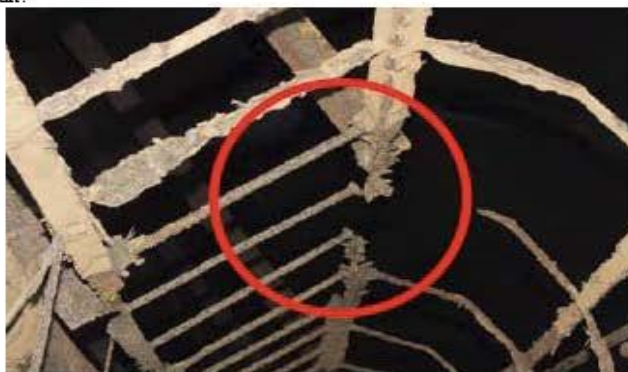
1.kép. Víztoronyban lévő közlekedő létra
