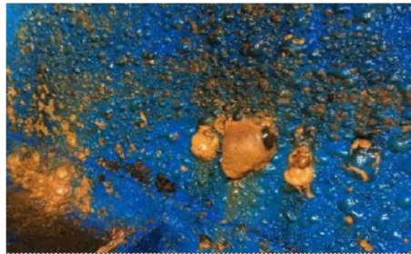
2.kép Csőoszlop belső felülete
